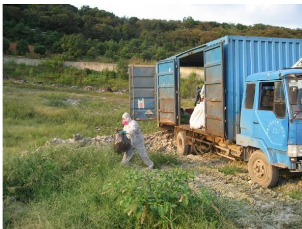
图 4.47 石棉填埋处理
