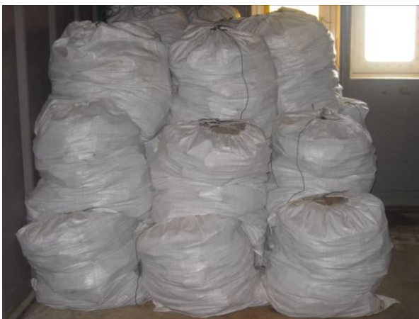
图 4.46 双层袋密封拆解后的石棉
