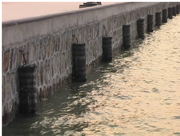
图 4.50 剥离导线制成码头护舷
