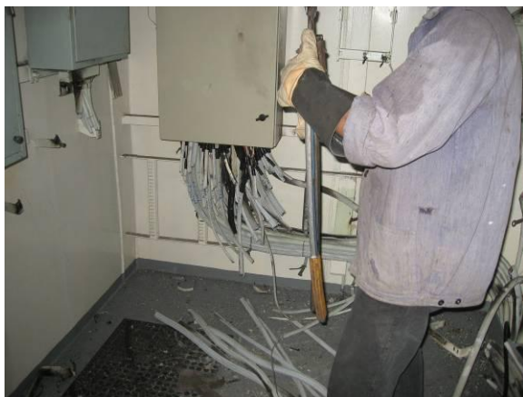
图 4.48 对船用电缆进行冷拆除
