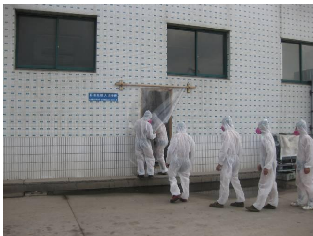
图 4.59 石棉施工人员浴室
