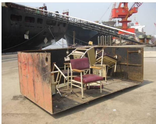
图 4.40 拆除舱室家具
