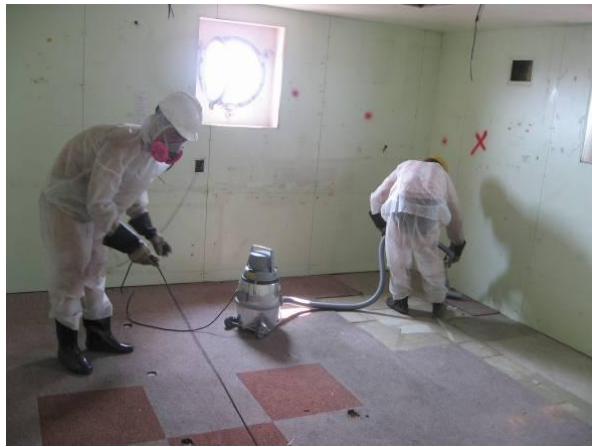
图 4.45 用专用吸尘器吸附石棉碎块
