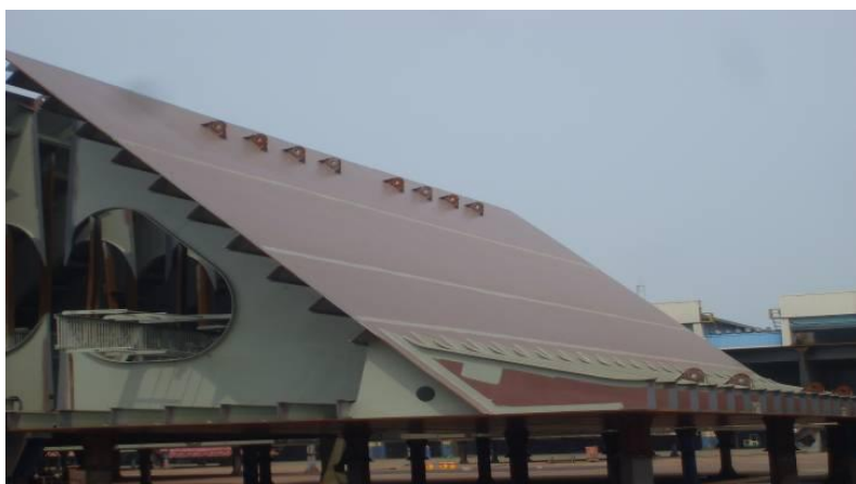
图 4.19 实施货舱施工工艺
