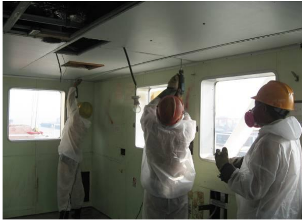
图 4.44 对石棉进行冷拆解
