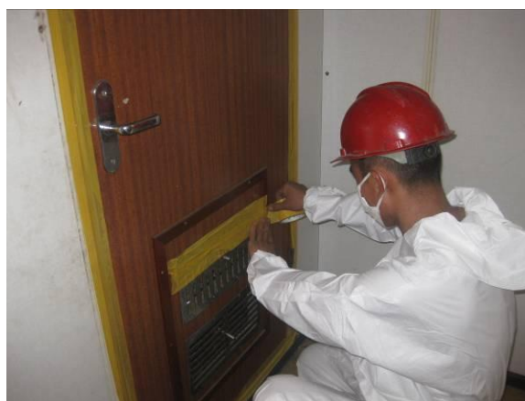
图 4.43 密闭处理石棉拆解区域
