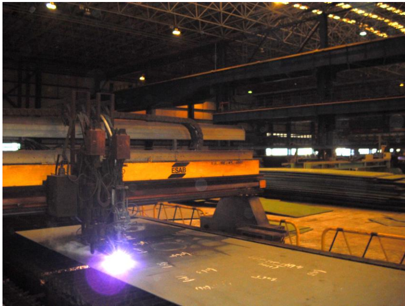
图 4.32 开启吹风助力装置焊接现场
